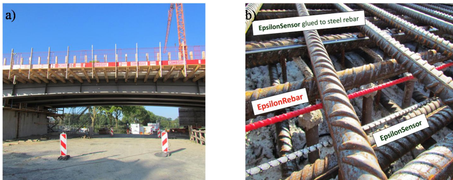
Rys. 3. Most kolejowy w miejscowości Sande w Niemczech: a) widok ogólny; b) zbliżenie na czujniki światłowodowe do pomiarów odkształceń betonu i prętów zbrojeniowych.
